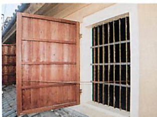
漆喰壁と片開きの鉄格子窓（二階）
