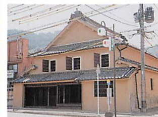
まちなみ交流館 旧松木家住宅（平成19年）
